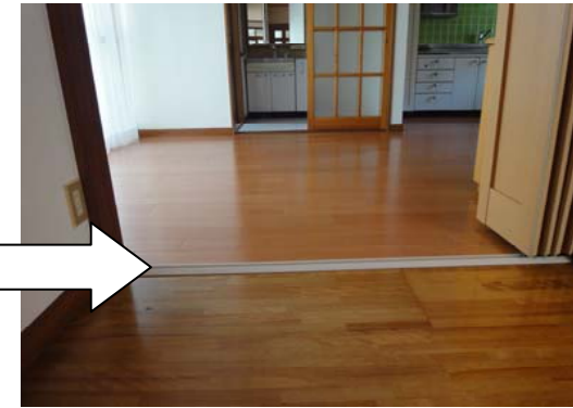
手前のフローリングは現状 奥のキッチンのフロアを レイフロアに張替え
